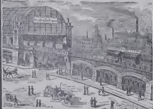
Hierbei mittelst unserer Asphaltfilzplatten 10000 qm Gewölbfläche isolirt
